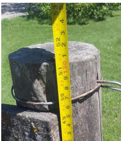
Altura de poste
