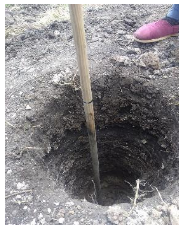
Varilla guía para medir profundidad
