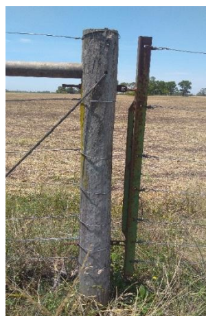
Fijado mediante varilla metálica
